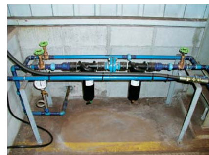
フィルター 1次・2次フィルターで水をろ過して生成機へ
